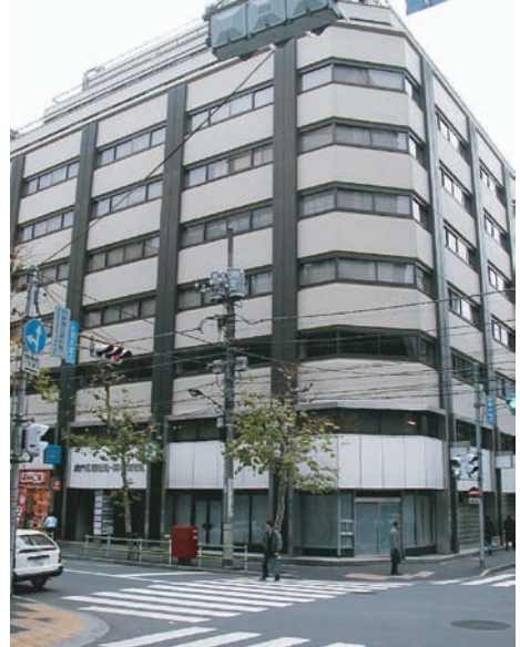
虎ノ門5 森ビル全景
