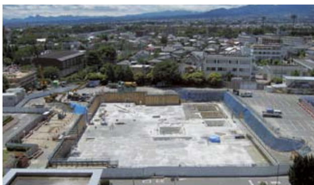
基礎工事の状況（2007年6月）
