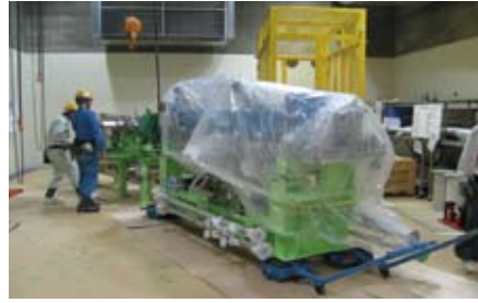
入射器の搬入・据付 工事が始まっている 写真：平成20年9月
