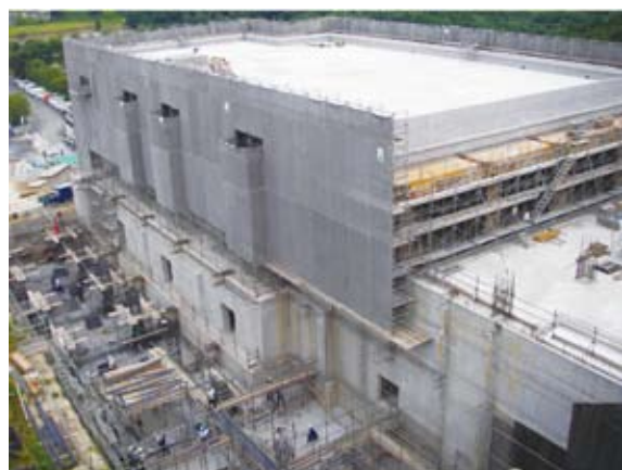
施設外観（平成21年7月撮影）
