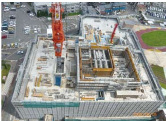
鉄筋・型枠工事
