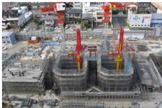
平成22年10月初旬の建設状況
