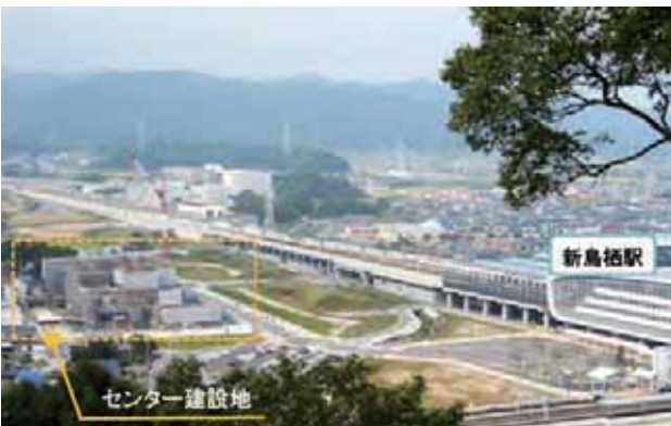
平成 23 年 10 月初旬の建設状況（地上躯体工事段階）
