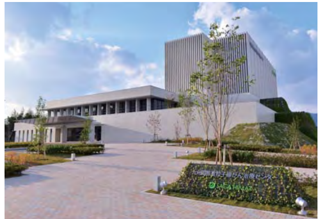
完成したサガハイマツト（平成 24 年 11 月 7 日撮影）
