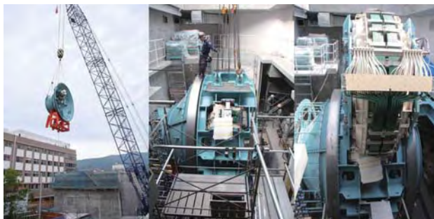
回転ガントリ据付工事
