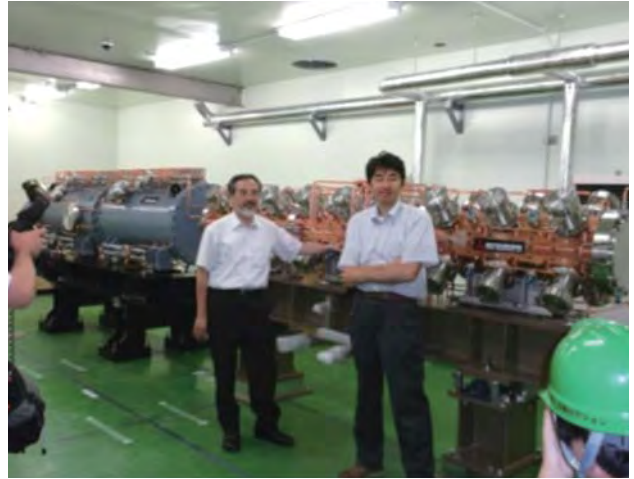
東海村での加速器見学ツアー 加速器本体部分の設置が終了し、今後ターゲット部分の制作が始まる。
