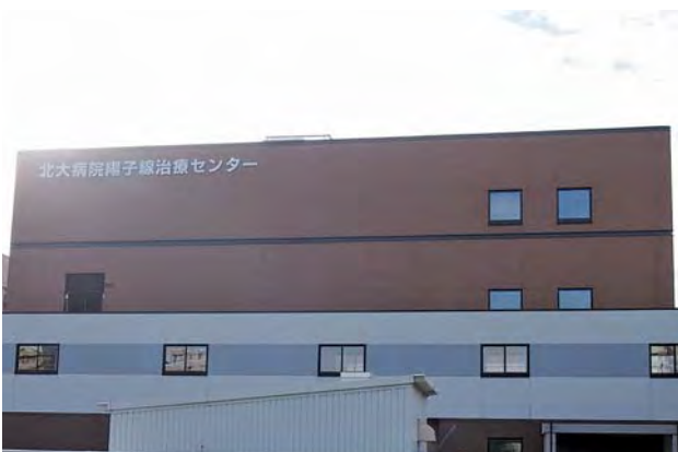
北大病院陽子線治療センターの建屋
