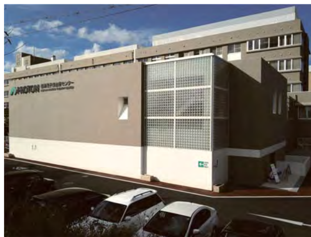
図1 相澤病院 陽子線治療センター
