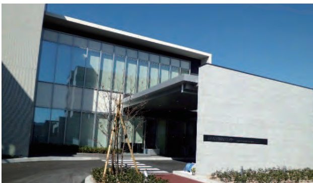
TOP BEAM 外観
