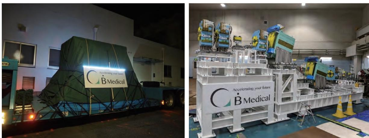
図7. 左：偏向電磁石搬送の様子、右：装置据付の様子
