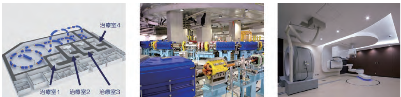
図3 i-ROCK (左：ビームライン構成, 中：加速器室, 右：治療室)
